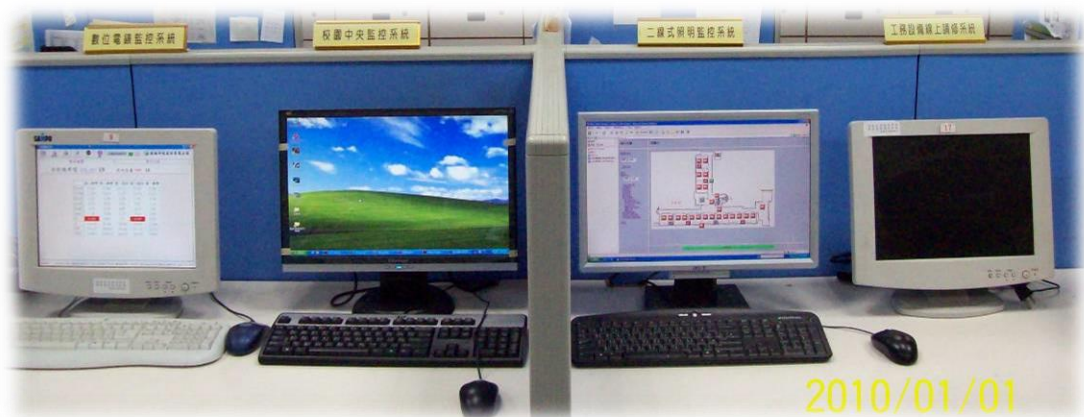
中央監控系統、數位電表、照明二線式燈光時間控制系統
